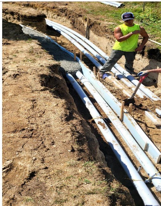
tele data conduit in process of pour
