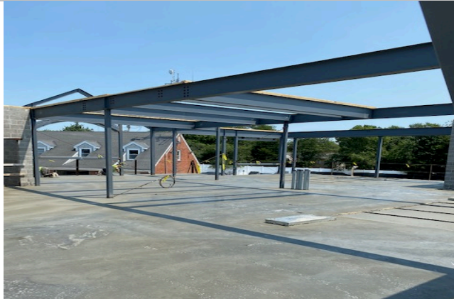
Finished Slab on Deck Pour
